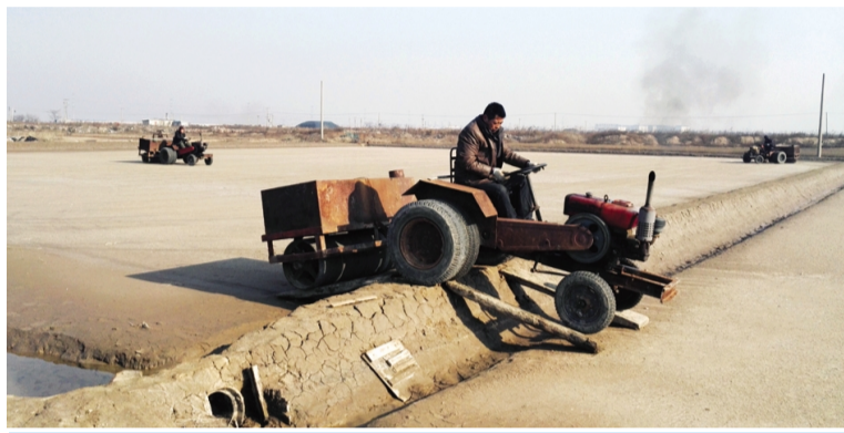
日前,徐圩投资公司抢抓连续晴天时,迅速推进池板晾晒工作,及时出动21台压路机,明确限期包片责任,加大现场安全工作指导力度,及时抢抓压路板1150块近40000亩,为全面开展春晒制卤生产工作奠定基础。(陈洪祥 侍作华)
